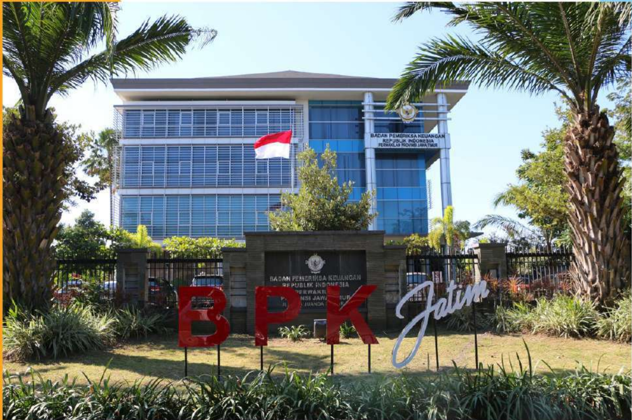
>> Gedung Kantor BPK Perwakilan Provinsi Jawa Timur
