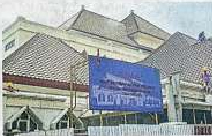
HAMPIR TUNTAS: Pekerja melaksanakan rehabilitasi IGD RSUD Bhakti Dharmas Husada kemarin. Proyek itu dirampangkan pada November.
